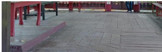
Gambar Tampak lantai papan *Baileo* yang disusun secara Horizontal, Vertikal dan Diagonal
